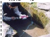
水路のひび割れ補修
